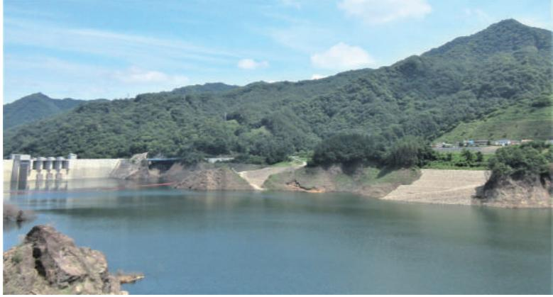
←八ッ場ダム周辺一帯は、2万5千年前に噴火した浅間山からの泥流が押し寄せ、堆積した土地。地滑り危険地帯だらけだが、国交省は危険基準も示さず、対策も不十分なままである。ダム湖岸には、押さえ盛り土で地滑り対策をしている箇所があちこちに。本来なら鉄鋼の杭を打ちこむべきところ、工事費削減で盛土のみ。安全性より経済性優先か。
