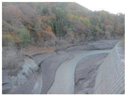
←昨年11月12日の上流部分。台風19号で大量の土砂が流入し、数メートルの高さまで堆積した。
