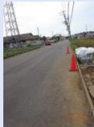
事故現場。傾いた電柱が事故の衝撃を物語っています。
