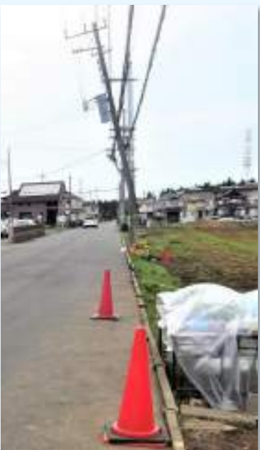
事故現場。傾いた電柱が衝突の激しさを物語っています。献花台には雨よけがかけられていました。
