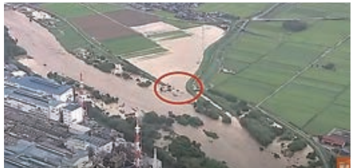
8月5日 滋賀県高時川の氾濫。赤丸の箇所がかすみ堤。溢れた水が田んぼに流れ出ている。
