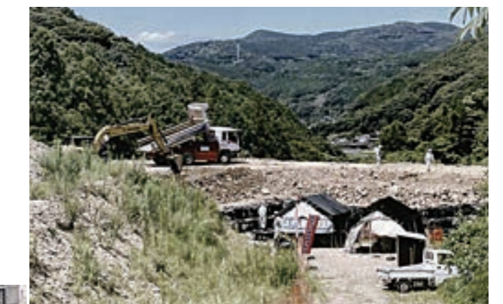
抗議の座り込み用テントのギリギリまで土砂を投入。2023.8.4
