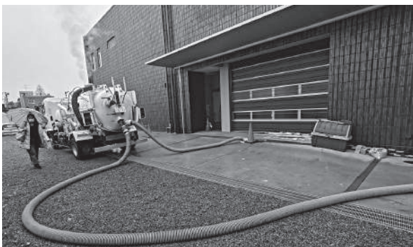
図書館前のバキュームカー 3/5
