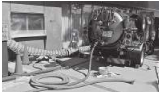
↑大型のバキュームカーで、図書館床下から汚水を汲み出し中
