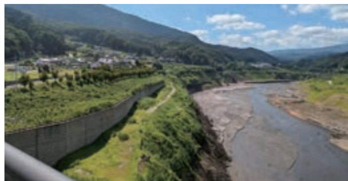
ダム湖の中でも上流側の丸岩大橋付近は堆砂が進んでいる。
